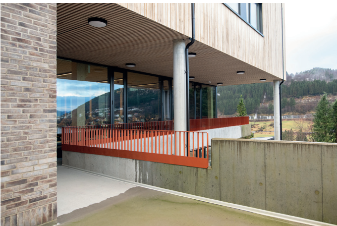
Utkraving på byggets nordside.
