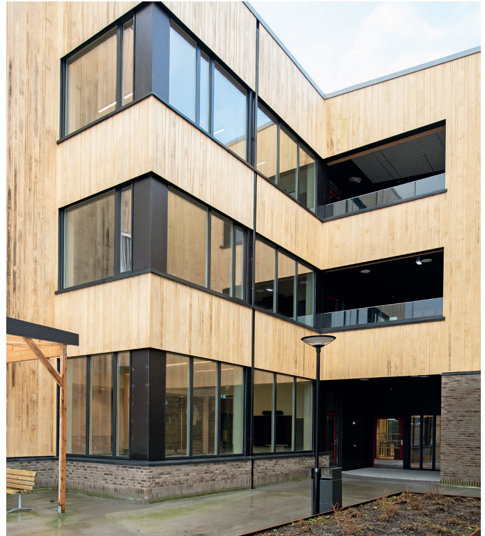
Vinduer mot området mellom lamellene.
