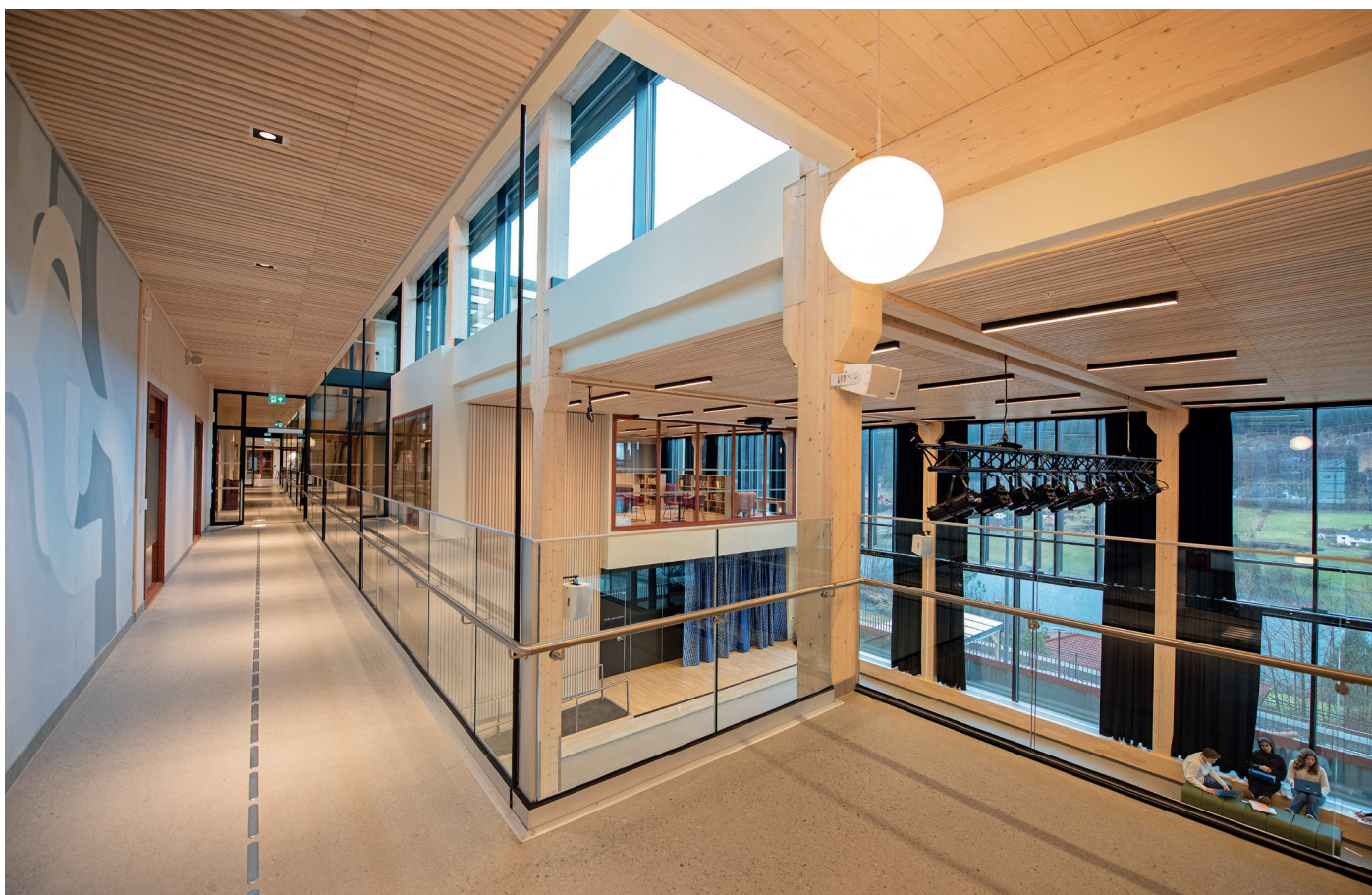
Det er mye frilagt treverk i bygget.
